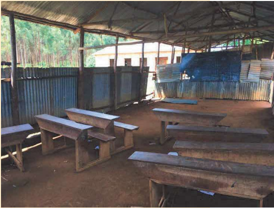
Bild der bestehenden Schule:
