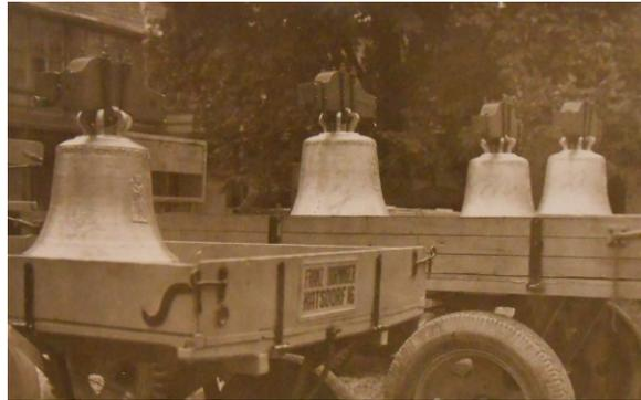
**GLOCKE 1 „Vitusglocke“:** Gewicht **601 kg**, Durchmesser 99 cm, Ton gis<sup>1</sup>
